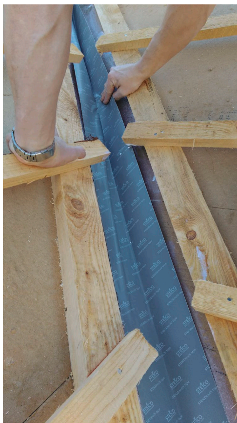
Uszczelnienie styku zagruntowanych płyt nakrokwiowych przy użyciu taśmy STEICOmulti tape F. Fot. STEICO
