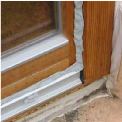
Abb. 5: Abkitten von Fensterfugen gegen die Schallübertragung über Baukörpernebenwege
