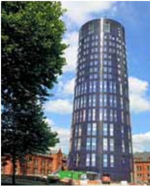
La tour en construction
