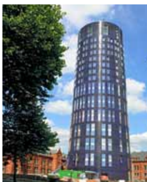
La tour en construction
