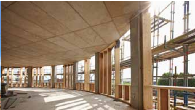
Les poutres de STEICOjoist en chantier
